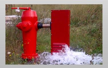
AUTOMATED - ADVANCED MAINTENANCE FLUSHING 135 GPM FOR 4 MINUTES PER DAY TO MAINTAIN CHLORINE RESIDUAL
