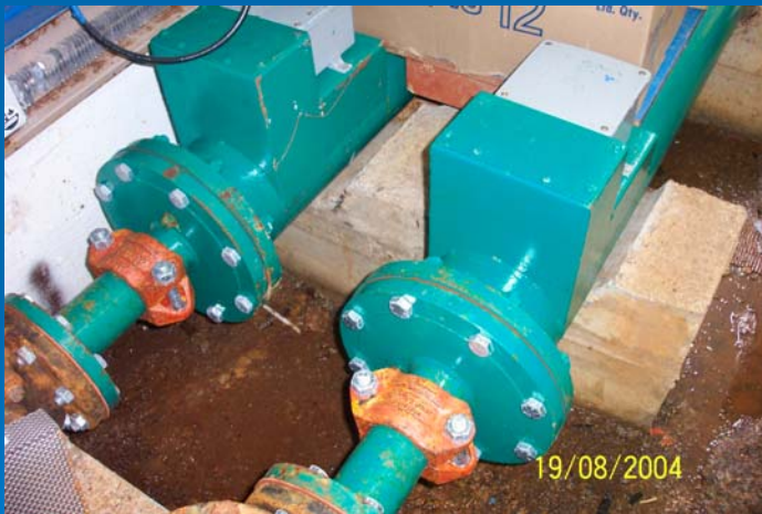
In-Line Booster (Turbine)
