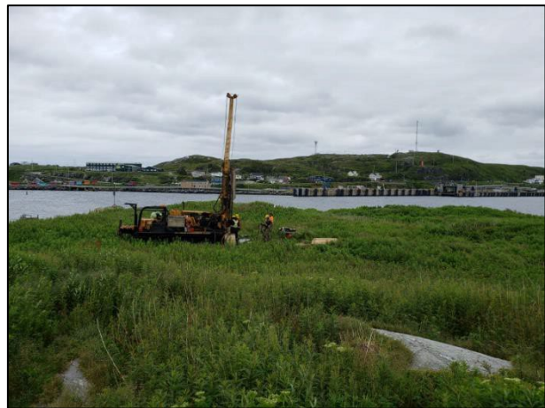
Photo A : Vue des opérations de forage sur la rive sud de l'île.
